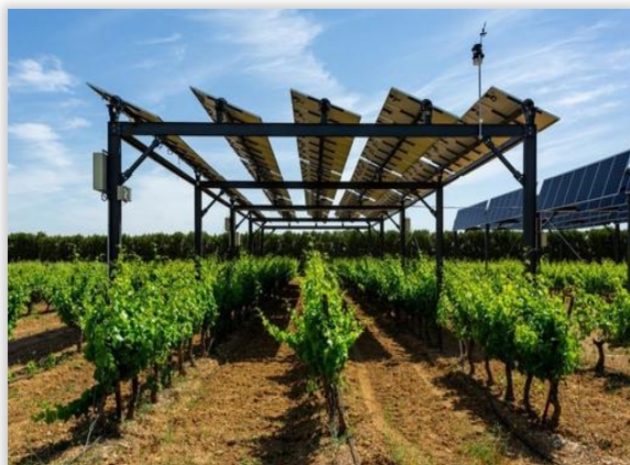
Figura 10. Estructura de seguimiento solar fotovoltaica.
