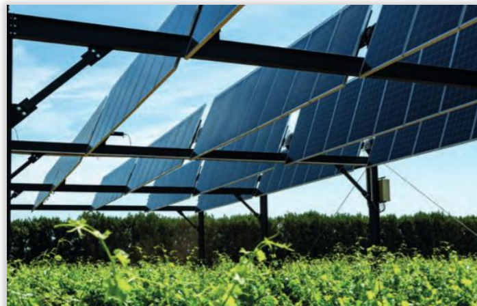
Figura 11. Sistema de eje único en Francia © Sun Agri.
