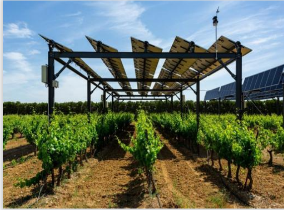
Figura 10. Estructura de seguimiento solar fotovoltaica.
